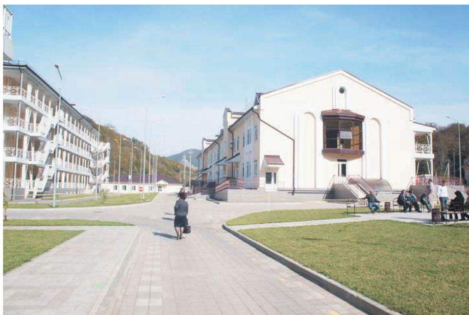
Новое здание инфекционной больницы № 2, п. Дагомыс
